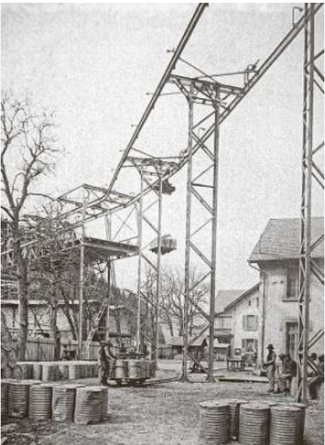
Die Rohstoffe Koks und gebrannter Kalk wurden vom Depot beim Thusner Bahnhof mit der «Hochbahn» direkt in die Fabrik transportiert. Das Karbid wurde in die Fässer im Vordergrund eingefüllt und versandt. Bild Archiv Bühler AG
