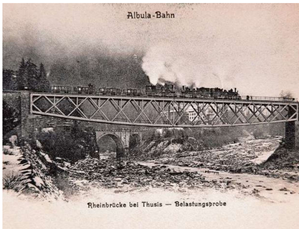
Standgehalten: Im Dezember 1901 bestand die Rheinbrücke die Belastungsprobe mit drei knapp 50 Tonnen schweren Dampflokomotiven und sechs schwer beladenen Güterwagen. Bild Anton Reinhardt
