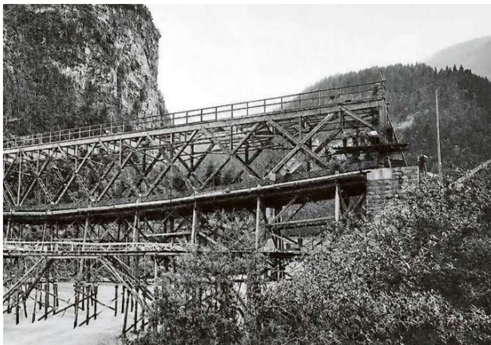
Das von Richard Coray errichtete Montage-Gerüst der Thusner Rheinbrücke.
